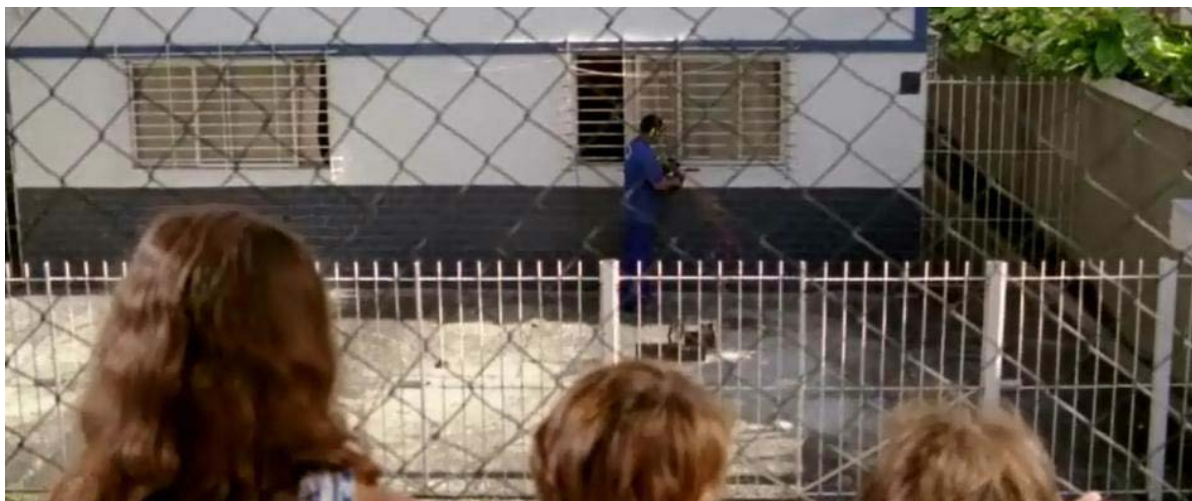
Figura 04 – Crianças observam instalação de grades em quadra de condomínio.
