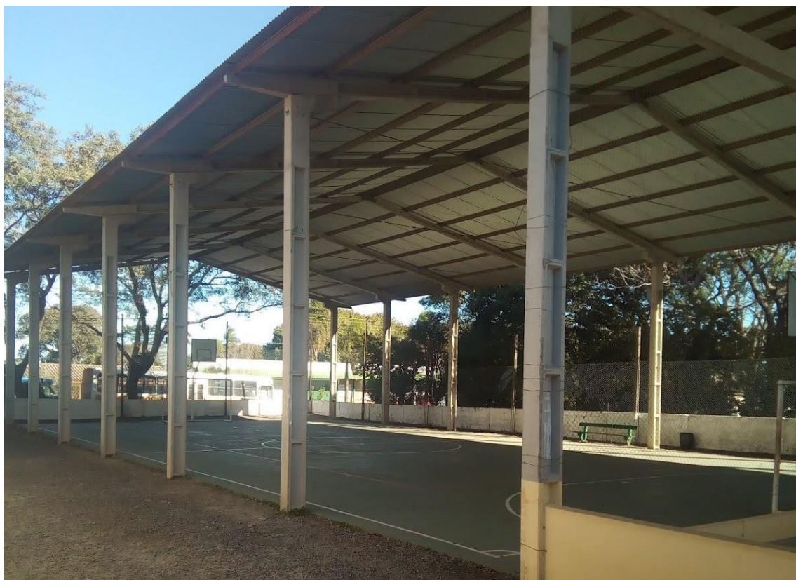
Quadra de esportes da escola: cobertura e quadra
